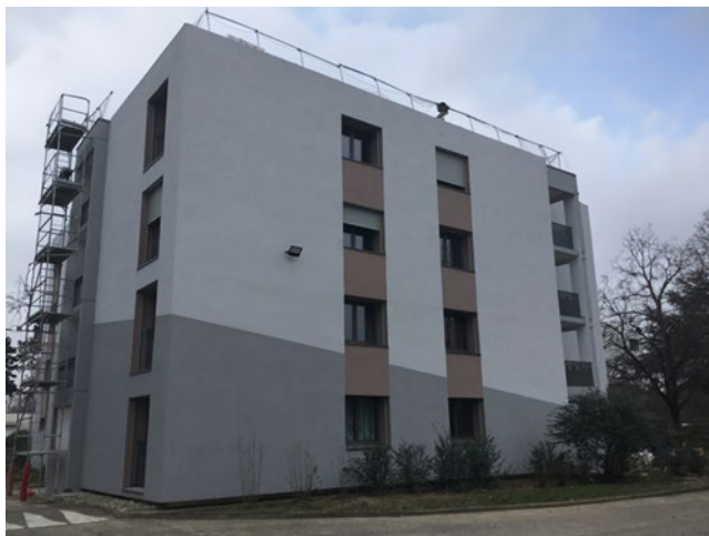
Résidence Petit-Bois – 6, rue de l'Industrie – Saint-Priest (69) – 105 logements
